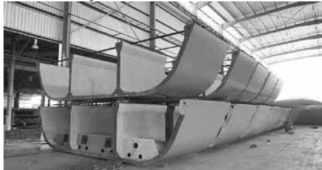
Hình 23. Dầm U UHPC phân đoạn căng sau
