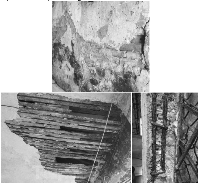
Hình 3. Các loại vật liệu xây dựng (gạch xây, vữa chất, cốt thép, bê tông cốt liệu sỏi) ở thể kỉ trước đều có chất lượng thấp nên bị suy giảm chất lượng nhanh
