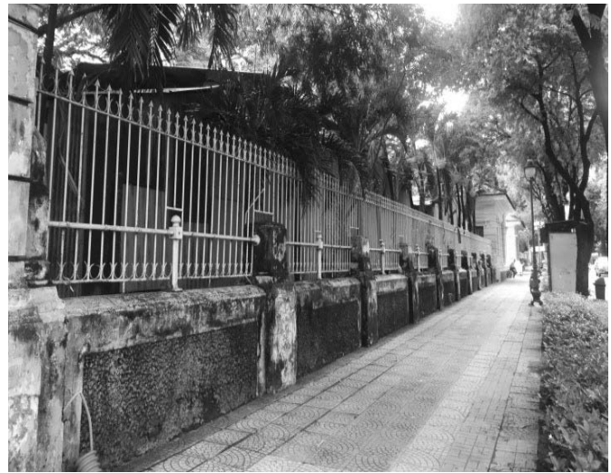
Hình 29. Tường rào và công trình phụ
