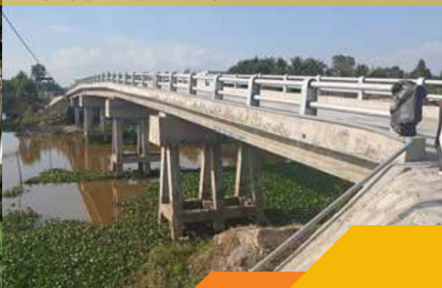
Cầu Vàng, thị trấn Thanh Sơn, Phú Thọ, dầm nhịp 30m, tải xe 0.65 HL 93, bằng công nghệ bê tông siêu tính năng UHPC.
