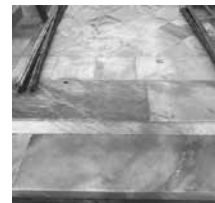
Hình 21. Thay đá ốp mặt cầu thang
