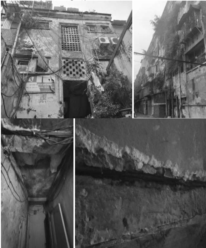
Hình 16. Được xây dựng từ khoảng 1970-1975 (An Dương, Lê Chân), cao 4 và 5 tầng theo lối thiết kế xây dựng Triều Tiên
