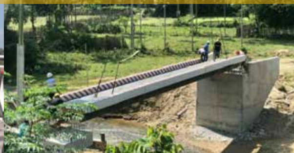
Cầu lắp dầm UHPC cầu Làng Cổ Thái Nguyên, 2018.
