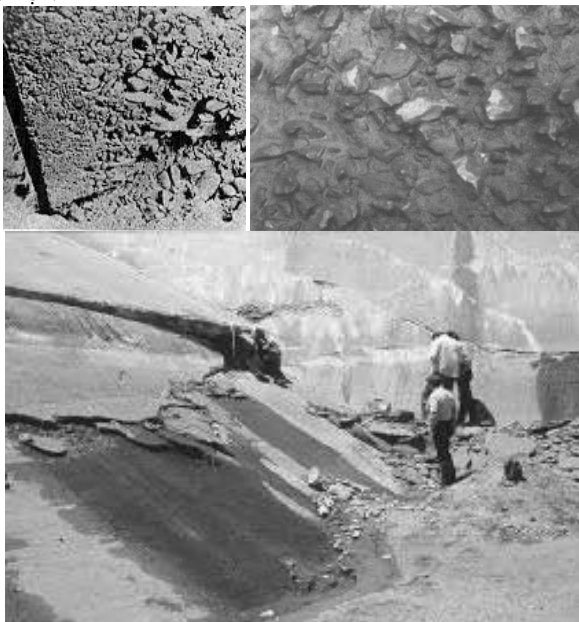
Hình 12. Mài mòn vỡ nứt bề mặt dòng nước mạnh và sóng biển
