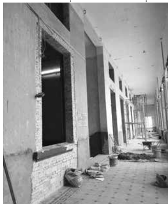
Hình 18. Trát bả, sơn lại tường [2]
