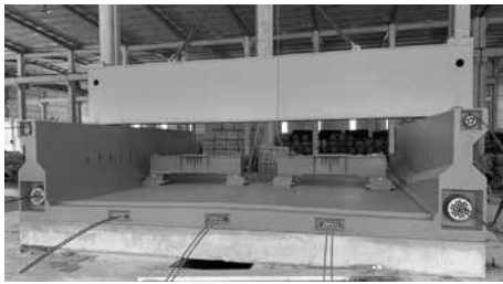
Hình 20. Dầm U phân đoạn - căng sau của dự án cầu Vàng (Phú Thọ)
