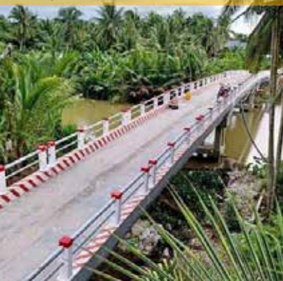
Cầu Từ Ô, Tiểu Cấn, Vĩnh Long 3 nhịp x20m bằng UHPC liên tục nhiệt 2018.
