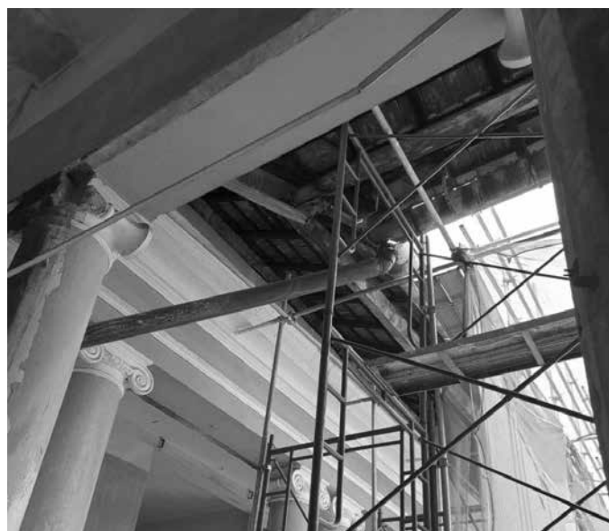
Hình 26. Thay mới hệ thống thu nước
